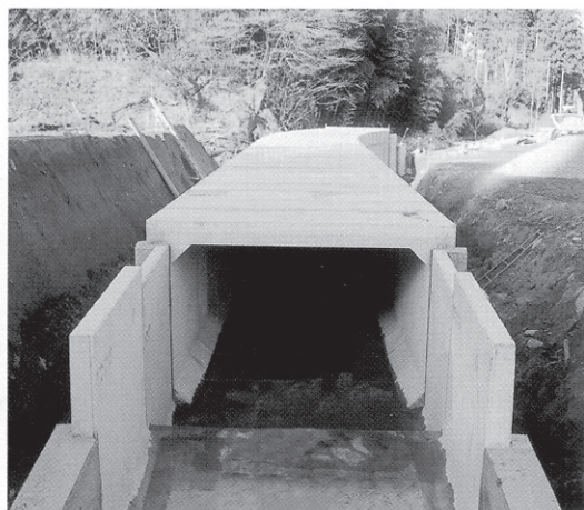
石川町ボックスカルバート敷設
