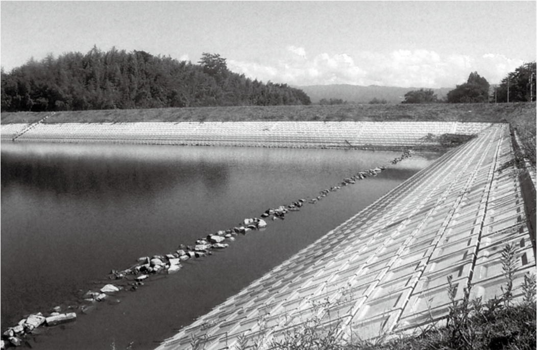
張ブロック施工
