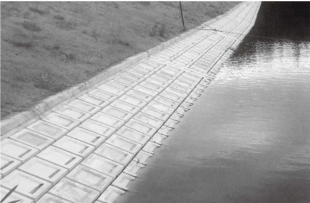
張ブロック施工
