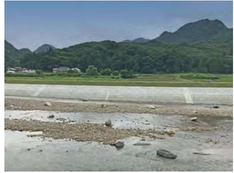
館岩川(南会津建設事務所管内)
